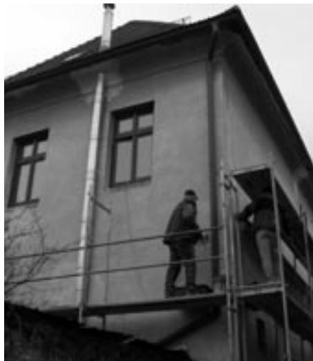
Při rekonstrukci fary
