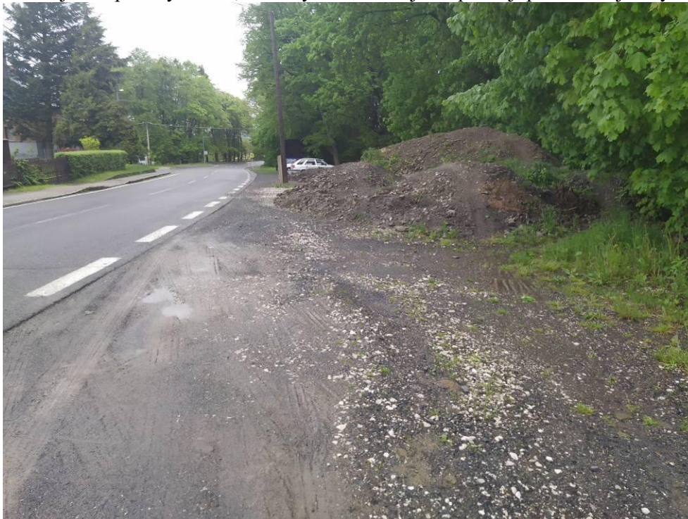
Foto 14: Antropogenně narušený okraj podél komunikace s deponiemi materiálu a navazujícími porosty dřevin, ve kterých se v okrajích uplatňují především jasaný a javory.
