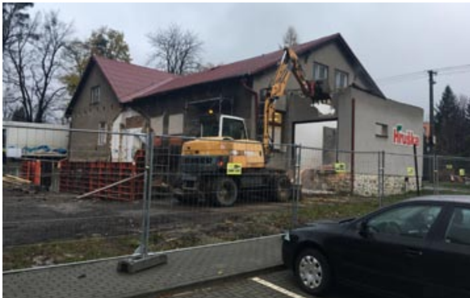
Bourací práce u obchodu na Lomné
