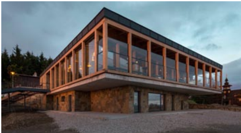
Nová horní stanice lanové dráhy
