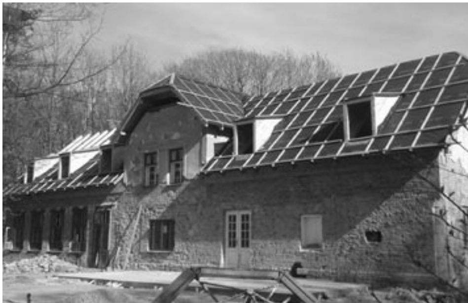
Restaurace Rekovice - stav k 25. dubnu 2015
