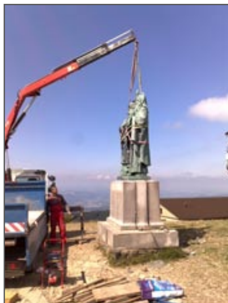
Oprava podstavce sousoší sv. Cyrila a Metoděje
