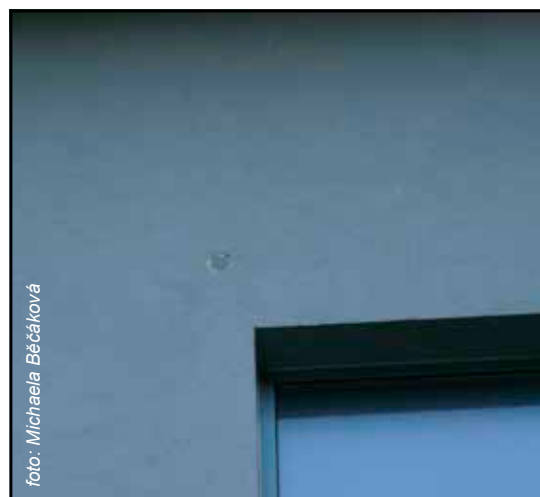
Precizní práce - otvory v izolací vrstvě budovy základní školy nápadně připomínají otvory do dutiny na stromech.
