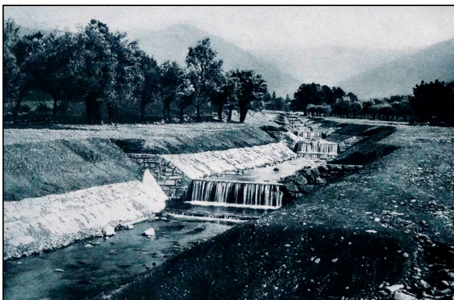
Hrazení bystřin. Bystřina Lomná před hrazením a po hrazení.** Později byly po obou březích vybudovány turistické chodníky. V pozadí Okruhly a Mjaši.
